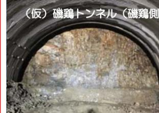
(仮)磯鶏トンネル（磯鶏側）の掘削を行っています。全長1,554m（845mを大成建設で施工）のうち509mまで進んでいます。
