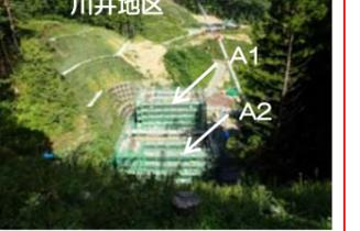
(仮)上川井橋A1橋台、A2橋台ではコンクリート打設を行っています。
