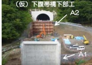
(仮)下腹帯橋A1橋台は、施工が完了しました。A2橋台では深礎杭の掘削作業を行っています。
