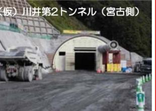
(仮)川井第2トンネルの掘削を行っています。全長1,782mのうち108mまで進んでいます。
