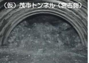
(仮)茂市トンネルの掘削を行っています。全長1,885mのうち540mまで進んでいます。
